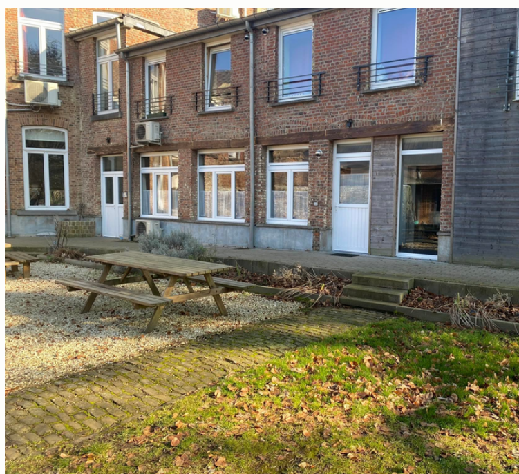
Intervention de Solidarité Logement pour l'aménagement des extérieurs sur le site d'Ath
